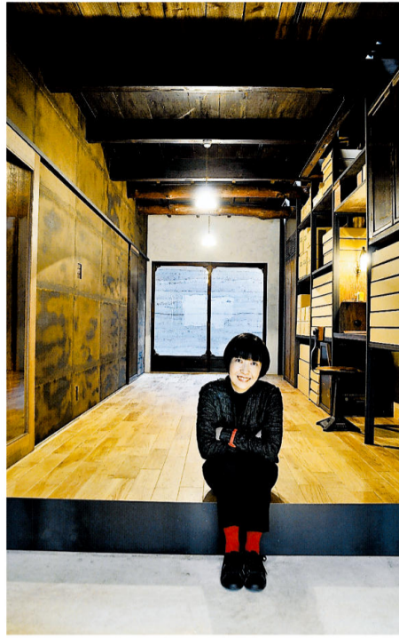
再生された長屋で美観を損ねる通称「壁紙剥がれ」を貼った上から漆を塗り仕上げている。右は設備収納
