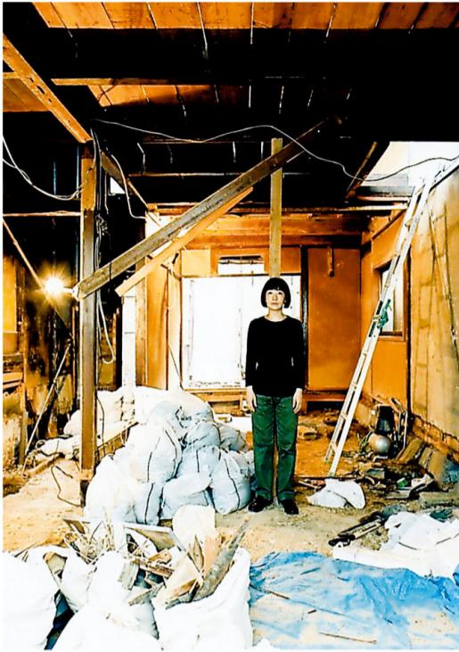
解体作業で新建材が一掃された1階にたたずむ通崎さん。建築当初の土壁や梁、屋根裏が姿を現した2階部分。最終的に正面や右側の壁、屋根裏はこのまま生かして仕上げられた。いずれも平野愛さん撮影
